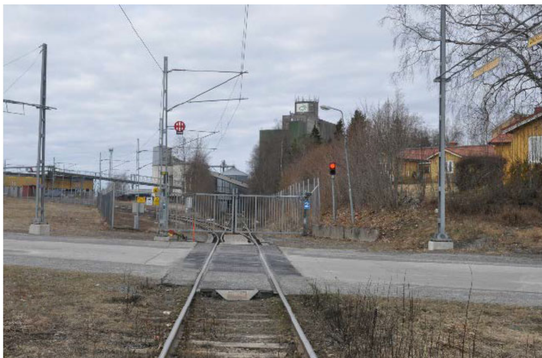
Järnvägs korsning vid Axel Enströms väg.
