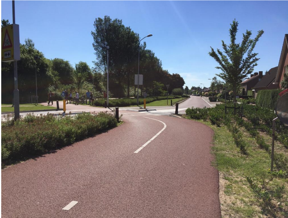
Figur 5-16 Sidbyte av cykelvägen där både bilvägen och cykelvägen vrids för att undvika en tvär korsning för cykelvägen (källa: https://www.bicycling.se/blogs/kriterisaksson/index.htm?tag=324 ).
