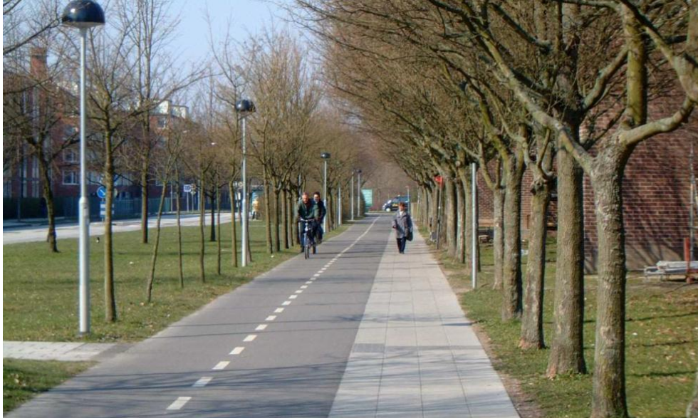
Figur 5-11 Exempel på en friliggande dubbelriktad gång- och cykelbana där fotgängare och cyklister är tydligt separerade från varandra med olika material (plattor för fotgängare och asfalt för cyklister). Notera att även körriktningar på cykelbanan är separerade med en mittlinje (källa: https://trafikverket.ineko.se/Files/sv-SE/11140/RelatedFiles/2009_154_separering_av_fotgangare_och_cyklister_forstudie.pdf ).
