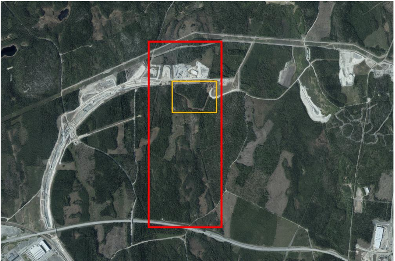
Figur 2: Ortofoto över området som visar bygget av Norrbotniabanan som påbörjats. Ortofotot är tagen under oktober 2022. Röd inramning visar området av intresse, orange inramning visar området där fördröjningsdammen ska anläggas. © Lantmäteriet.
