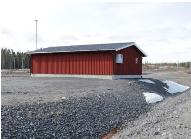
Figur 28. Punkt 10a. Pumpstation byggd i tidigare etapp.
