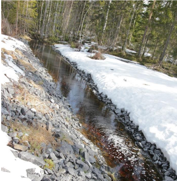
Figur 24. Punkt 6. Nytt dike innan övergång till befintligt dike som är ett gammalt vägdike. Strömmande vatten.
