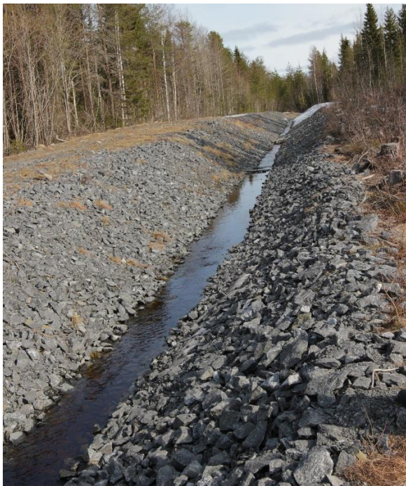
Figur 22. Punkt 4. Nytt dike in mot etapp 3. Rinnande vatten.
