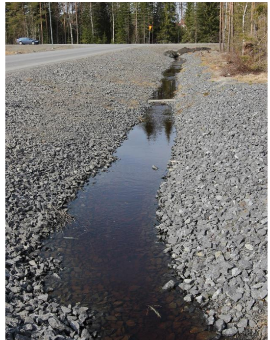
Figur 23. Punkt 5. Nyanlagt vägdike med lugnt rinnande vatten ansluts mot dike i punkt 4.
