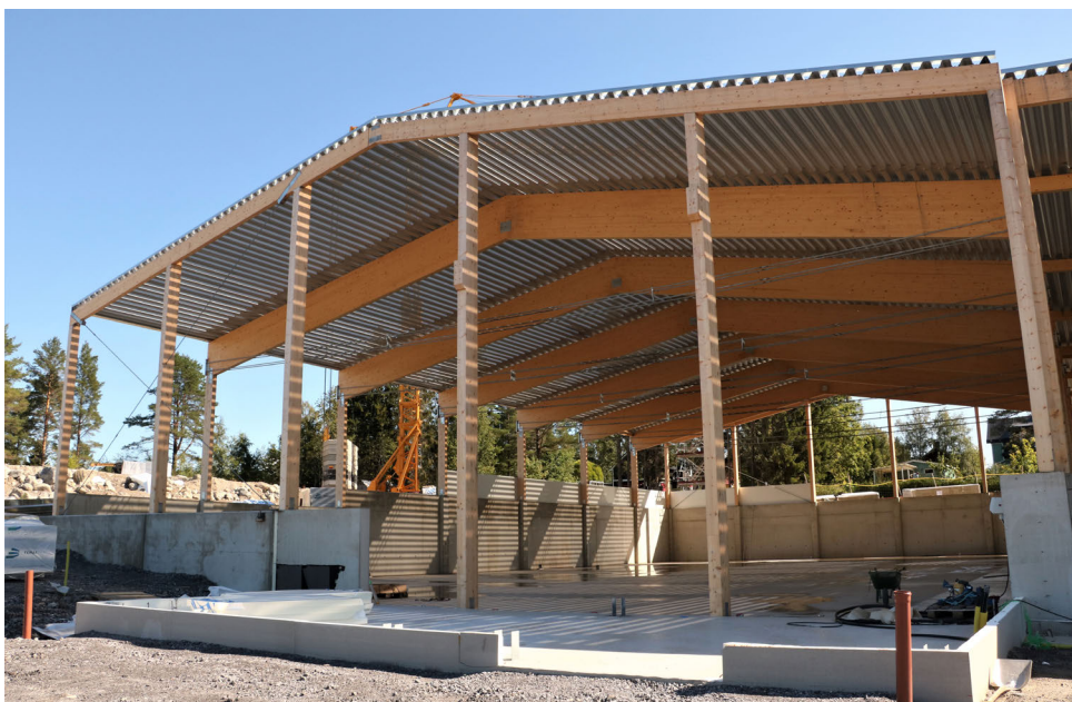
Bygget av Mötesplats Stöcke under sommaren 2021. Foto: Therese Burström.
