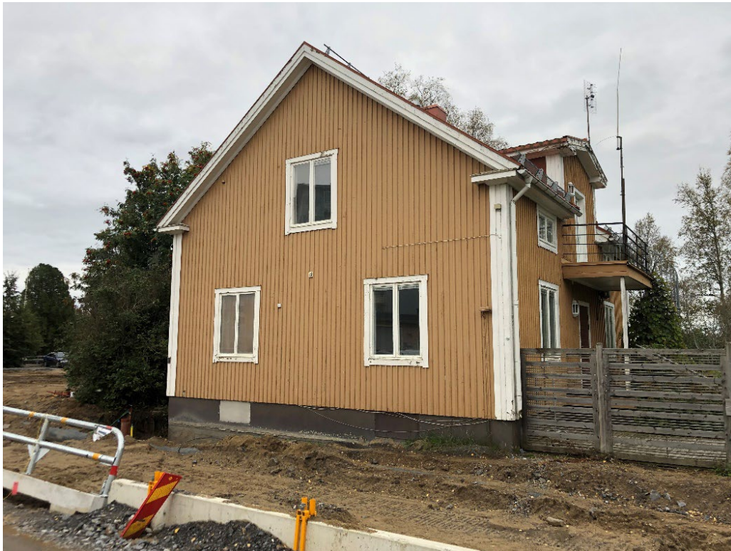
Umeå 5: 51, gavelfasaden mot Kvarnvägen
