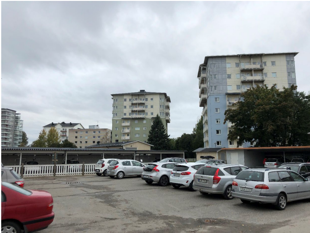
Punkthusen i kvarteret Plogen, uppförda under 1960-talet. Tre av dem har byggts på med fler våningar under tidigt 2000-tal. Parkeringsytor med skärmtak i förgrunden invid Kvarnvägen.
