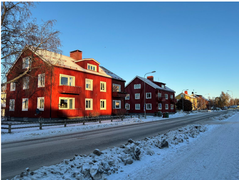
Små flerbostadshus vid Ängesvägen i kvarteren Hackan och Skäran. Ingår i bebyggelsemiljö med sammanhållen karaktär i Byggnadsordning för Väst på stan: 11 Små flerbostadshus vid Kvarnvägen och Ängesvägen, 1940-tal.
