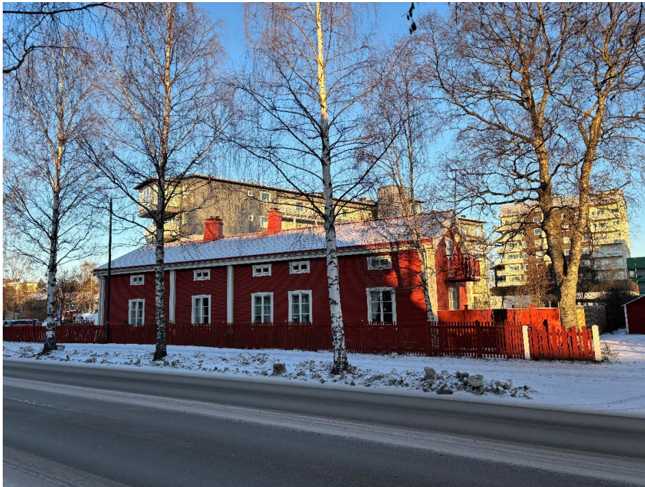
Mangårdsbyggnad till jordbruksgård i Ytterhiske by. På ursprunglig plats. Logen 17, Storgatan 5B. Utpekad som särskilt värdefull i Byggnadsordning för Väst på stan.
