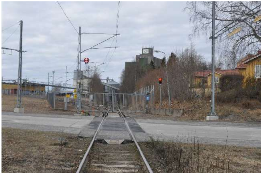
Järnvägskorsning vid Axel Enströms väg.
