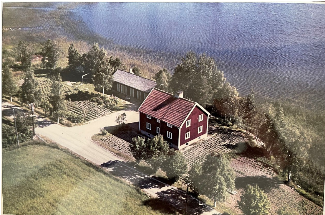
Figur 19 Flygfoto från år 1958. Befintlig huvudbyggnad på Tavelsjö 41:1 har ett sadeltak med centeradnock som är klädd med lertegel. Fasaden består av träpanel som målats i mörkröd kulör med vita knutar och vita fönsterfoder med mittpost.
