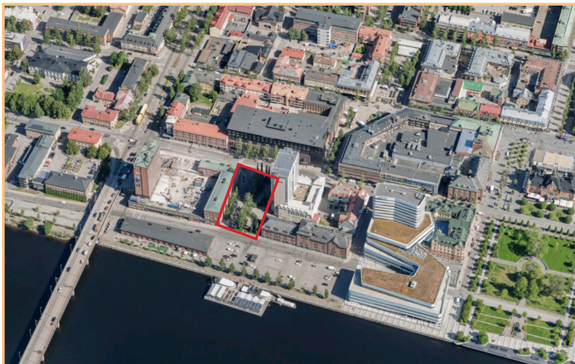
Figur 16. Flygfoto från 2019 med Brage 8 inringat i rött. I flygfotot framgår att Renmarksesplanaden har suddats ut som esplanad, men spår finns kvar vid stadsrummet kring Brage 8 som är markerat med rött. Källa: Umeå kommun, Open data.
