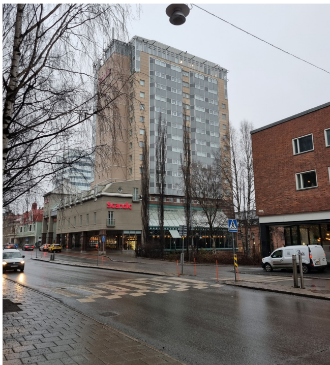
Figur 35. Foto över nuläge Storgatan. I mitten syns fastigheten Brage 8 med vegetation.
