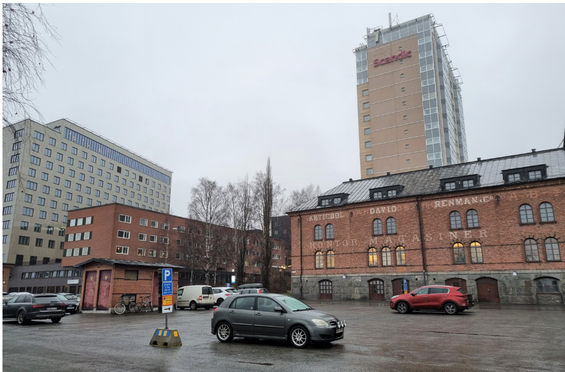
Figur 24. Vy från kajområdet mot gamla Tullmagasinet som syns till höger i bilden. Fastigheten Brage 8 syns till vänster om gamla Tullmagasinet. Plaza huset sticker upp bakom tullmagasinet.
