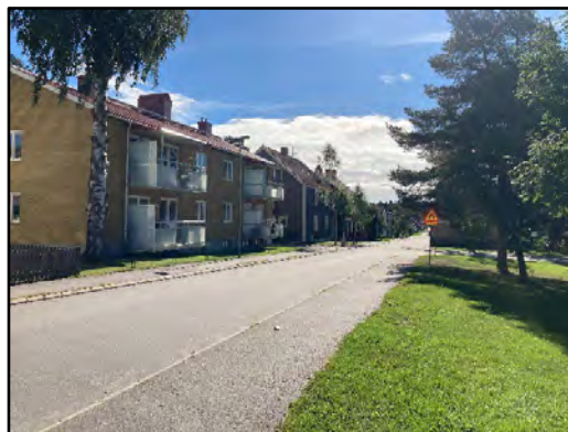
Figur 8. Södra Gimonäsvägen. Vy mot söder.
