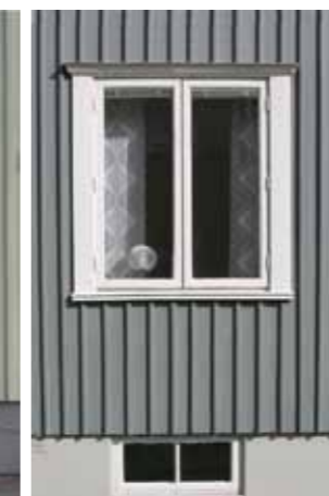
1940-tal. Tvåluftsfönster. Breda sidofoder.
