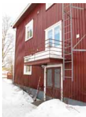
Hackan 5. Välbevarad funkisentré mot gården. Denis Sundberg 1940.
