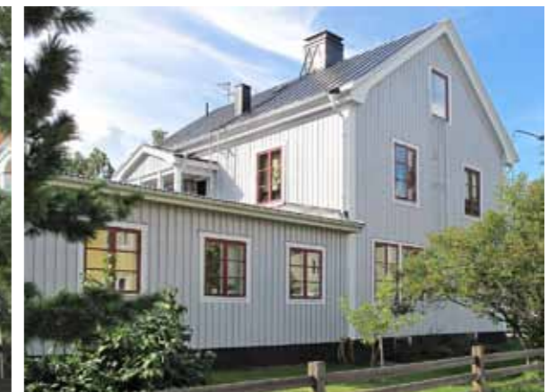
Skräddaren 7, Dragongatan 6B. Ivar Johansson 1923. Gathuset är ett bra exempel på fint anpassad om- och tillbyggnad.
