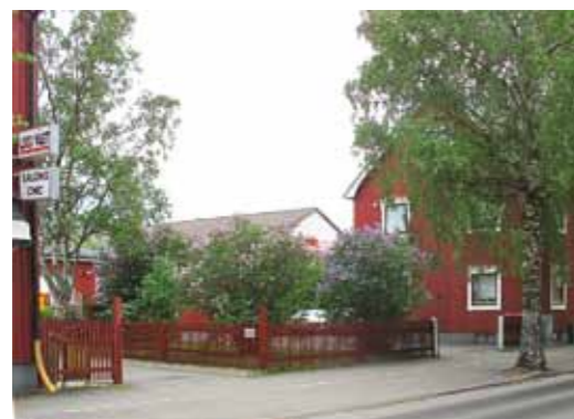
Här är öppningarna för bilutfart måttligt stora. Spjälstaket och gårdens syrenbuskar är positiva inslag i stadsbilden.
