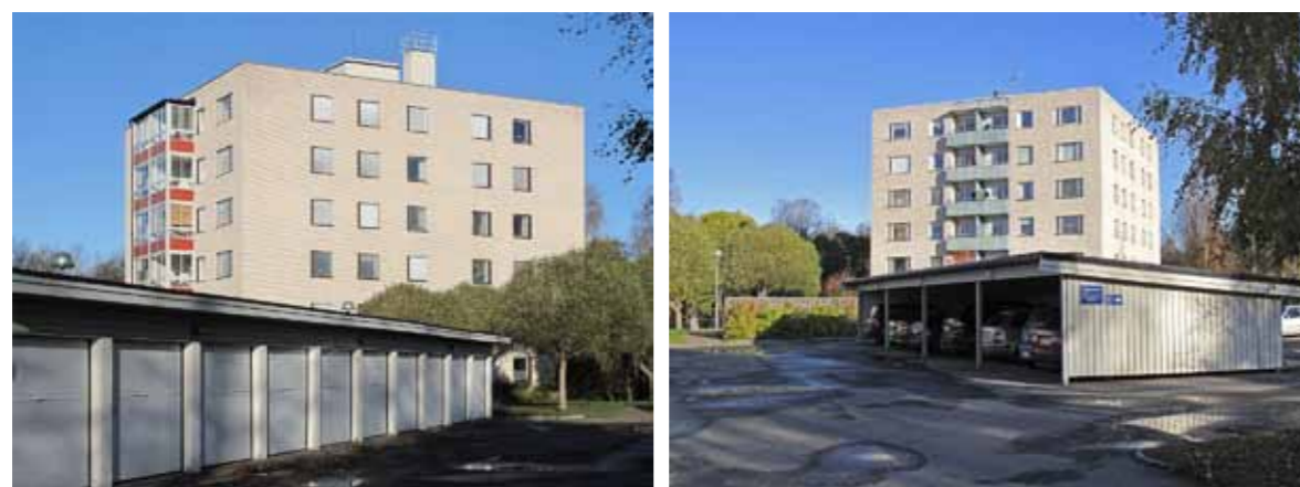
Plogen 18 och 19, Kvarnvägen 7-9 och 11 före planerad påbyggnad.
