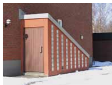
Smakfullt utformad källarnedgång med ljusinsläpp i glasbetong. Kvarnvägen 1.
