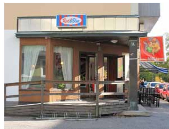
Ramp, mindre väl anpassad till husets arkitektur.
