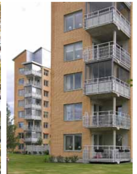
Gult tegel och gult fogbruk i vacker murning. Takvåningar klädda med galvad plåt.
