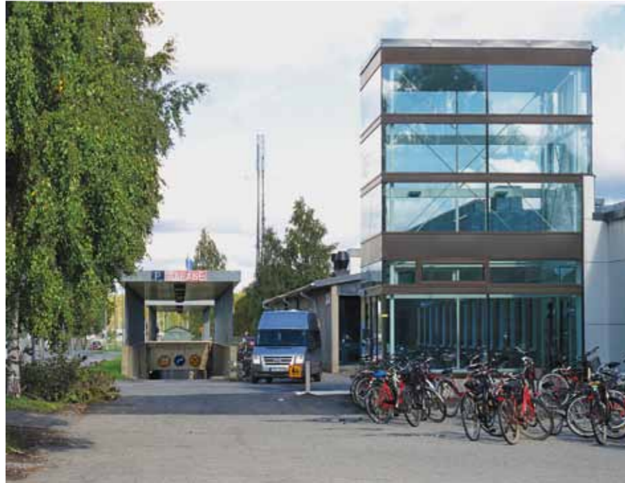
En av skolans tre nya huvudentréer. I bakgrunden skymtar nedfarten till skolans underjordiska parkeringsgarage.
