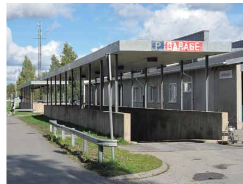
Nedfart till skolans underjordiska parkering. Längre bort skymtar uppfarten.
