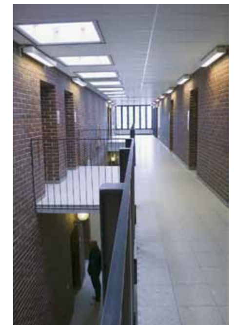
Loftgång till övervåningens klassrum med överljus och slitsar i bjälklaget som ger ljusinsläpp till våningen under.
