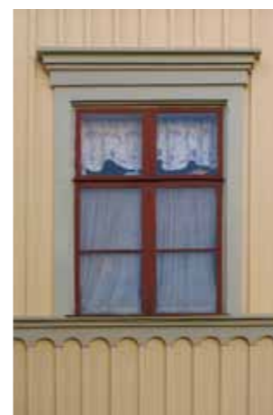
1880-tal. Korspostfönster m spröjs.
