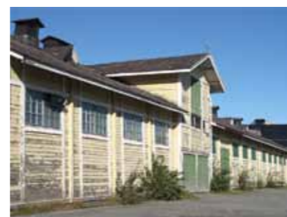
5. F d stallbyggnad, numera förråd.
