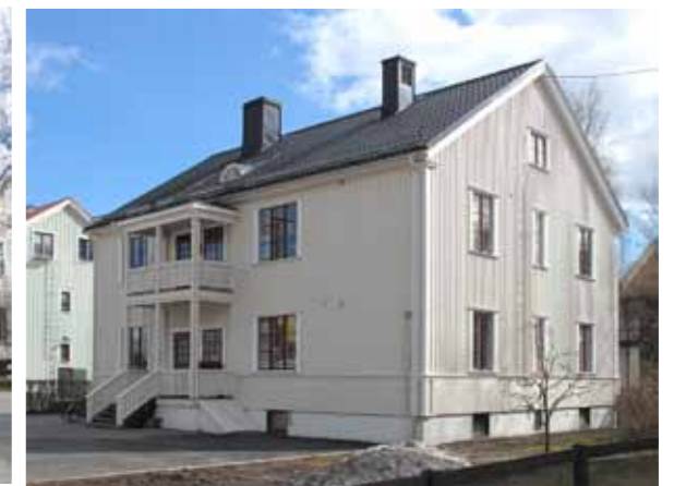
Smaragden 3, Storgatan 23A med treluftsfönster i köken och öppen tvåvåningsveranda mot gården.
