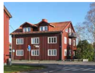
Kupor med sadeltak är mer påfallande än kupor med pulpettak. Här tillägg på 40-talshus.
