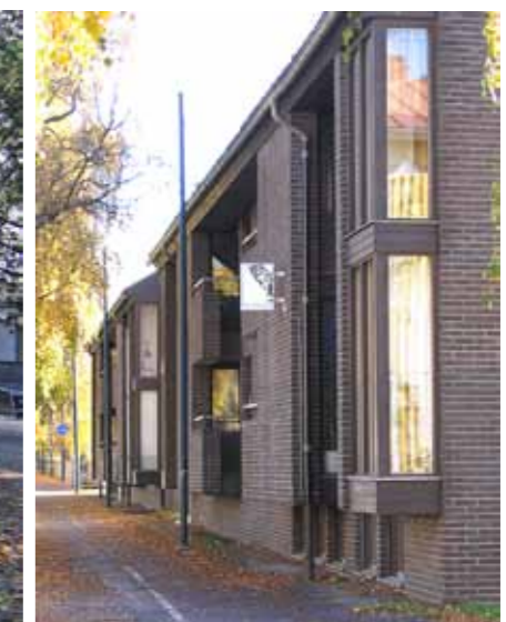
Burspråk och stående fönsterslitsar mot Storgatan.
