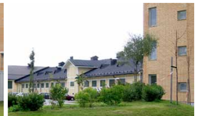
Parkering sker i K4:s gamla ridstallar som rustats för ändamålet.
