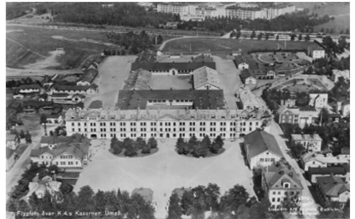
Regementet på 1950-talet. Kasernbyggnaden är tillbyggd åt väster och öster.
