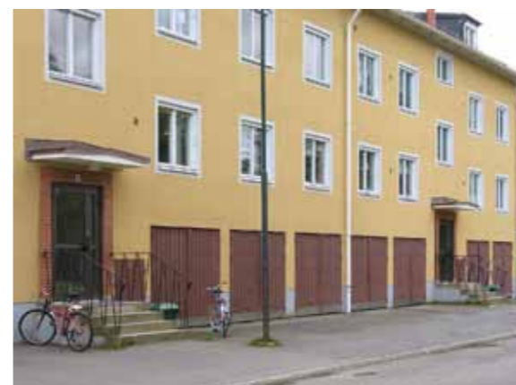
Västra Prinsgatan 2-4 med tidstypiska entréer och garageportar mot gatan.
