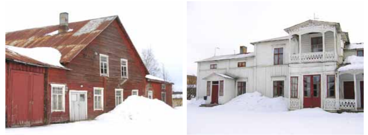
3. Ekonomibygnad och mangårdsbyggnad på fastigheten Umeå 5:5.
