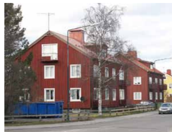
Hackan 6 och 15. Ängesvägen 3 och 5. Bortre takkupan ursprunglig.
