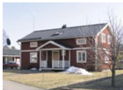
Detta sätt att dela fasaden hör inte hemma på äldre hus.
