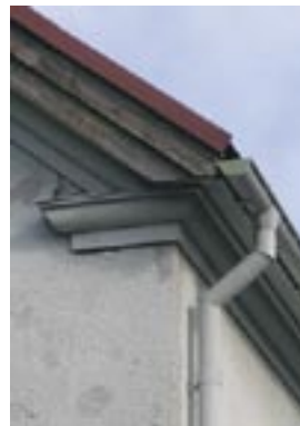
Stuprör med skarpt knä.
