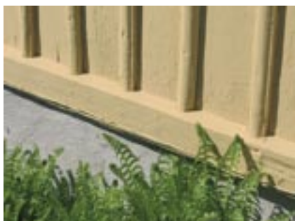
Sent 1800-tal. Profilerad locklistpanel.
