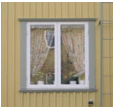
1930–50. Tvåluftsfönster med smala lister över och under fönstret och breda sidofoder.
