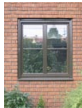
1970-tal. Enluftsfönster med korspröjs.
