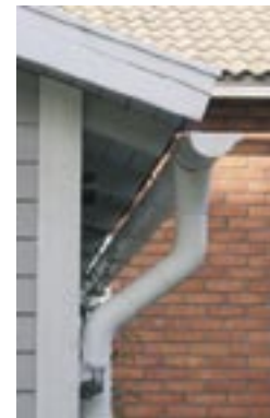
Stuprör med mjuk rörböj.
