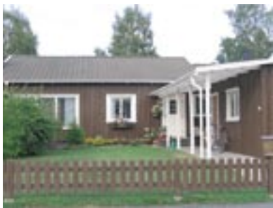
3A Kedjehus vid Monteringsgatan.
