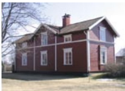
Liggande fasspontpanel inramad av horisontella och vertikala listverk var på modet 1890–1920.
