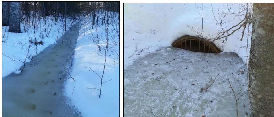
Figur 15. Bilder på befintlig bäck och dagvattenutlopp inom planområdet.
