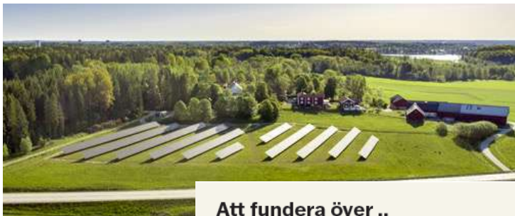
Foto: Linde energi
