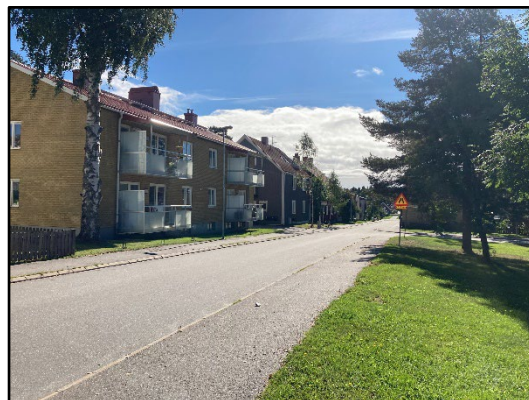
Figur 8. Södra Gimonäsvägen. Vy mot söder.
