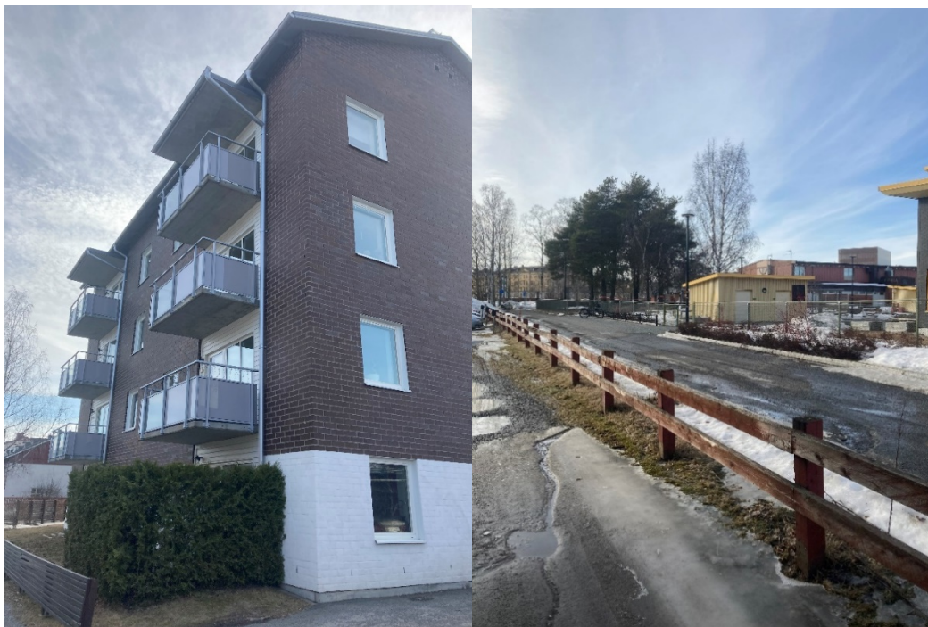
Befintlig bebyggelse direkt söder om planområdet.
