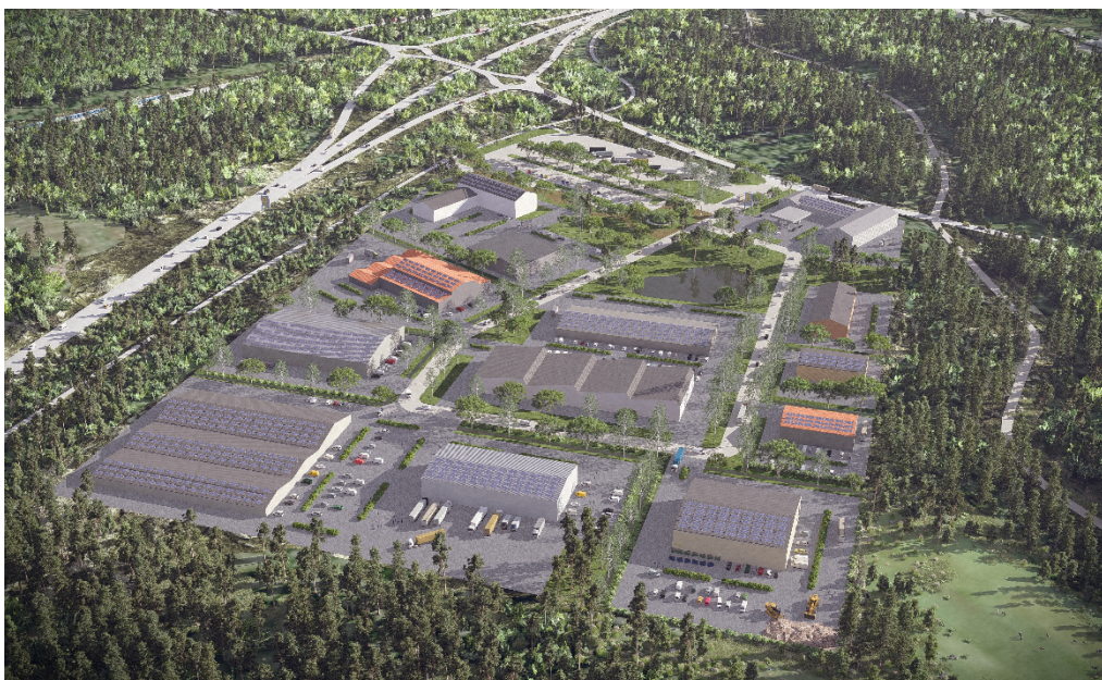
Figur 6 Visionsbilden framtagen av Link Arkitektur i ett tidigt skede av planarbetet och syftar till att illustrera en möjlig bebyggelsestruktur inom planområdet. Bilden är inte styrande utan ska ses som ett principiellt exempel. Visionsbilden avviker från plankartans reglerade markanvändning, bland annat genom att två större områden samt ett avlångt, smalt område för naturmark har tillkommit i den gällande plankartan. Bebyggelsens höjder i visionsbilden är framtagna för att ge en översiktlig indikation på vad som kan anses vara rimliga nockhöjder inom området, med hänsyn till terrängförhållanden samt närliggande bebyggelse och anläggningar.
