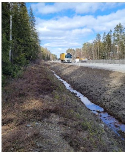
Figur 14. Befintligt dike längs med E4:an har en bredd på över 3 meter.
