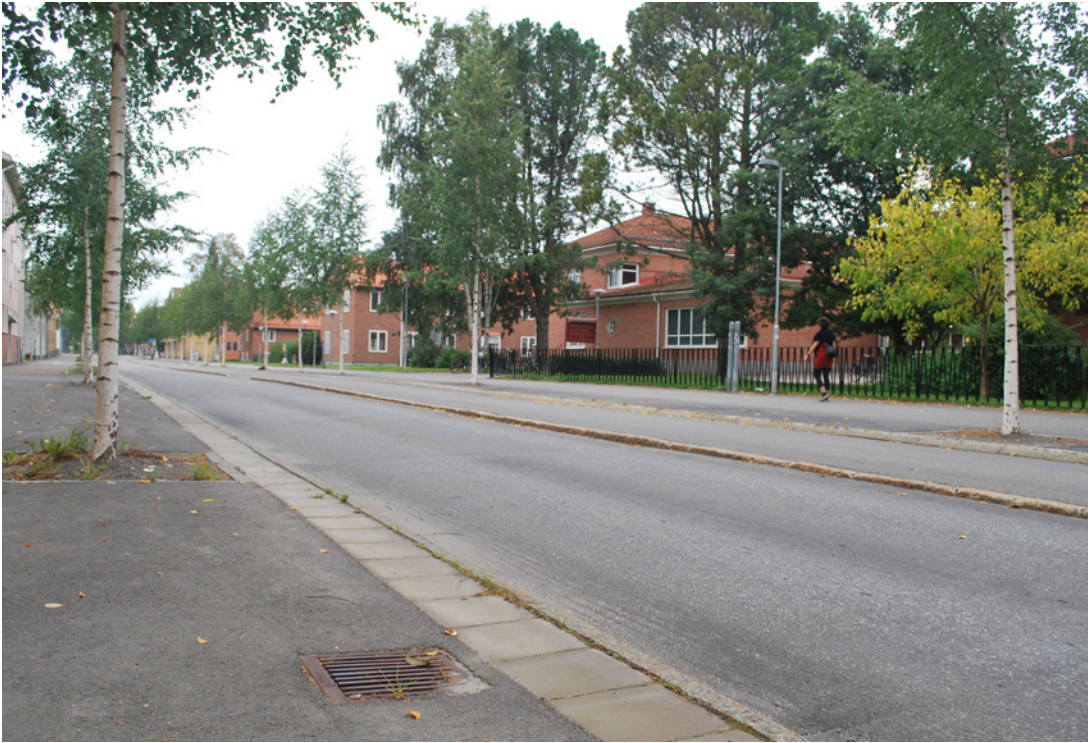
Trädplantering Nygatan, skelettjord med dagvattenbrunn.
