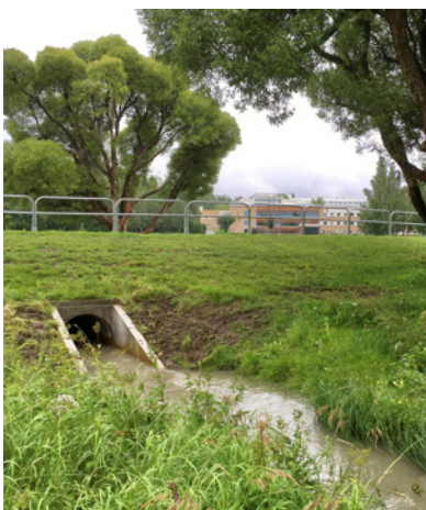
Campus. En ny trumma och en förhöjd vägbank kommer att dämma upp Sandbäcken vid skyfall. Gräsyrtorna uppströms trumman svämmar över och områdena kring Universitetsdammen löper mindre risk för översvämning.
