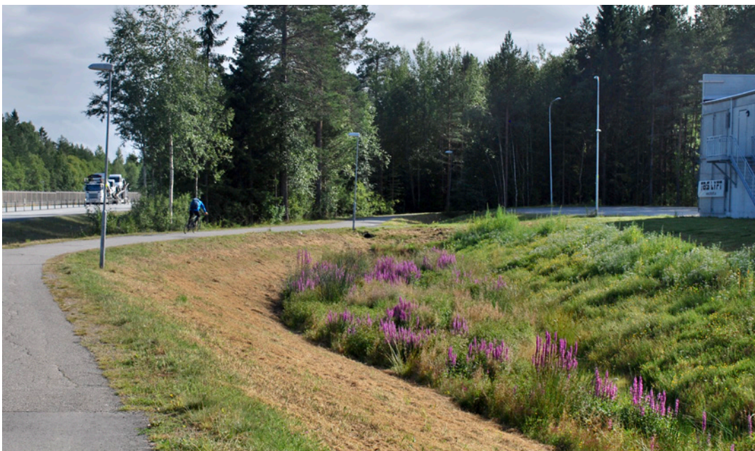
Olofsdal, vid Kolbäcksvägen. Dagvatten renas innan det når Nydalsjön.
