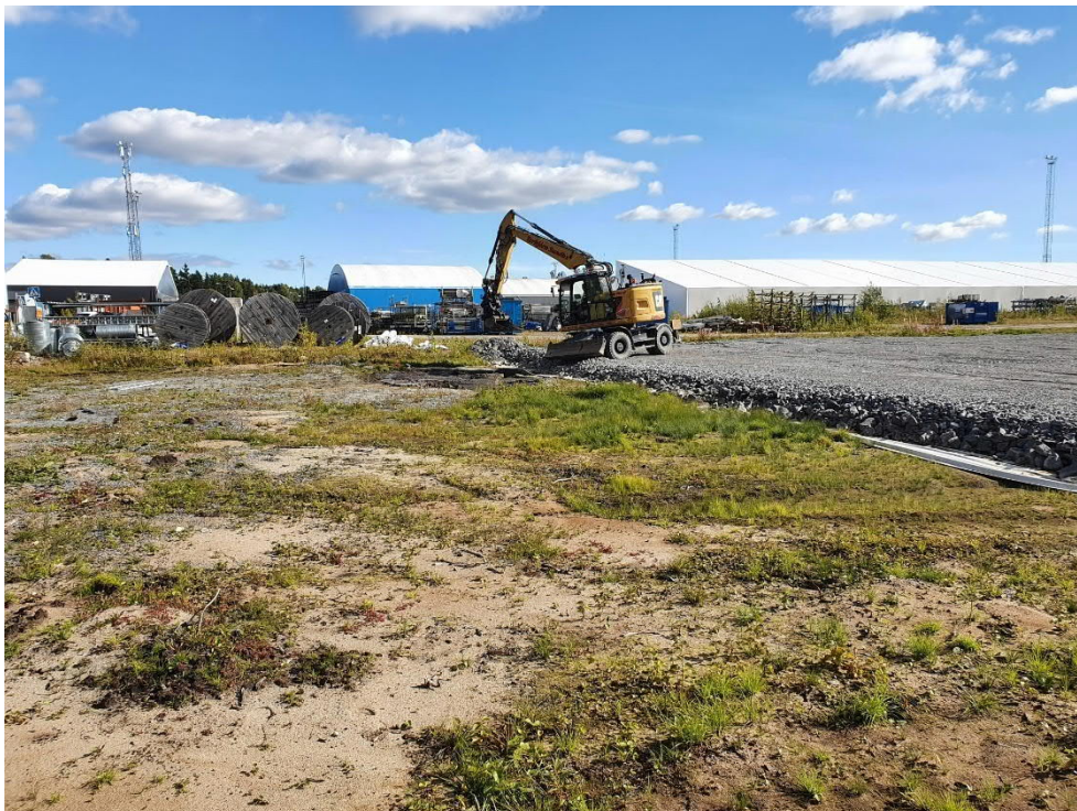
Figur 4 Foto i norra delen i östlig riktning. Till höger ses redan uppfylld yta. Grävaren står vid PG2.
