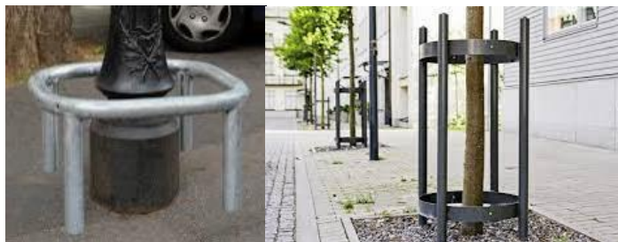
Exempel på Påkörningskydd
