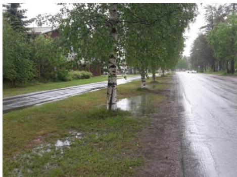
Figur 4. Ytavrinning och vattenansamling längs med Skravelsjövägen inom Befintlig bebyggelse . Foto: WSP Umeå
