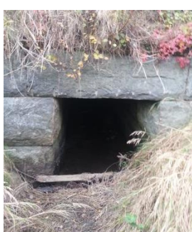
Figur 7. Stentrumma för Röbbäcken under Riksväg 522. Bäckens tidvis torr. Foto: WSP Umeå
