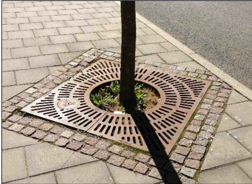
Figur 25. Figuren visar ett förslag på hur träd anlagda med skelettjord kan utformas i gatumiljö (WSP, 2013).
