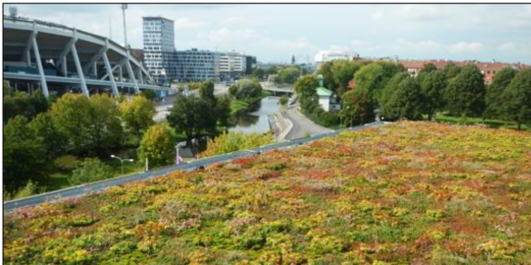
Figur 28. Exempelbild på gröna tak. Bilden är tagen från www.vegtech.se och visar ett sedumtak.
