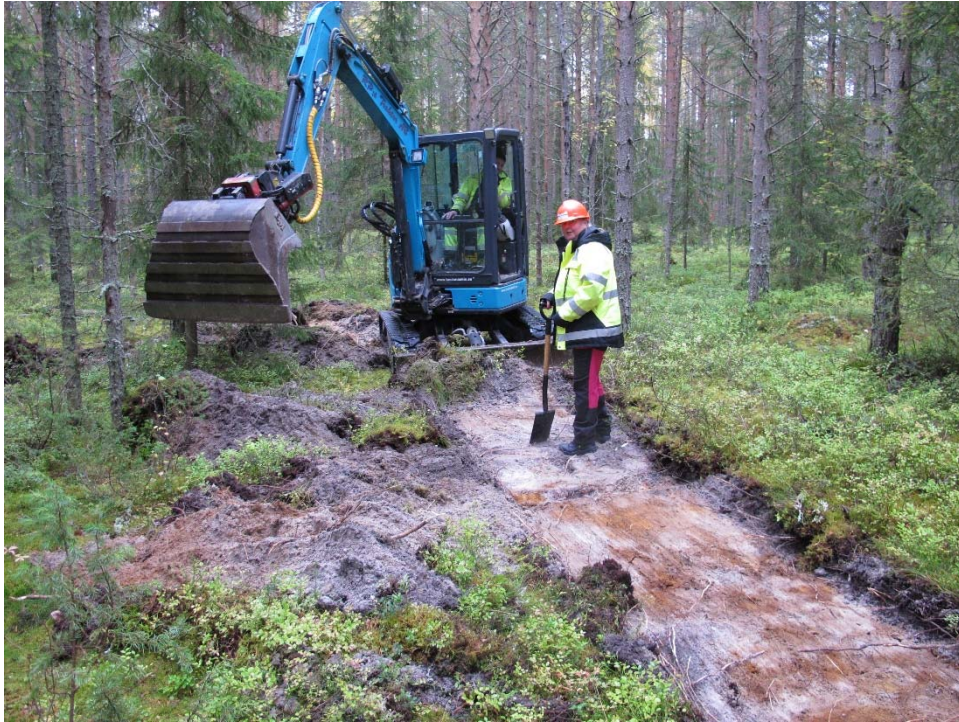
Bild 1. Berit Andersson övervakar schaktning.
