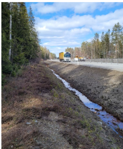
Figur 29. Befintligt dike längs med E4:an har en bredd på över 3 meter.
