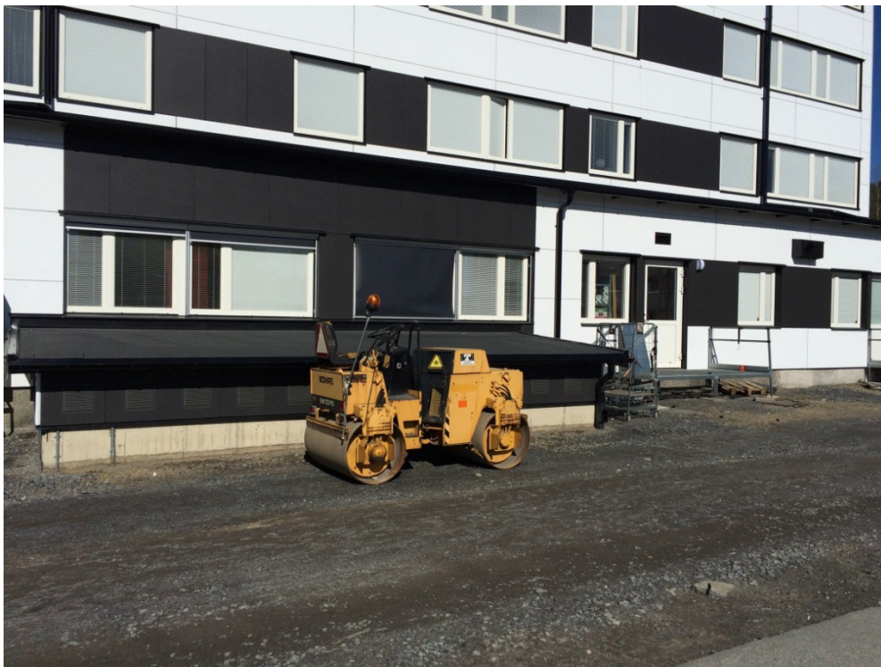
Figur 2. Östra sidan av byggnaden där det tidigare funnits en lastkaj som leder till källaren. Trappan finns kvar under utbyggnaden.
