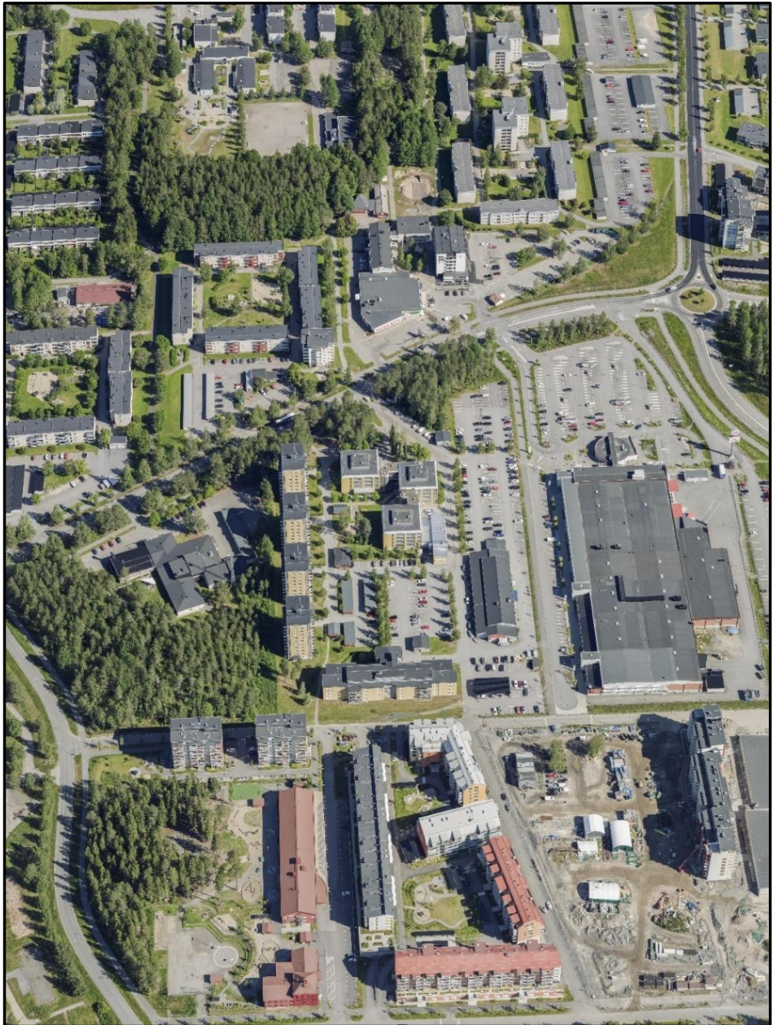
Figur 21. Flygfoto över Mariehems centrum med omgivning (Umeå open data)
