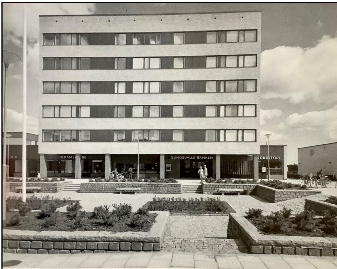
Figur 22. Ett nybyggt Mariehems centrum 1967. Foto: Bertil Ekholtz/Västerbottens museum
