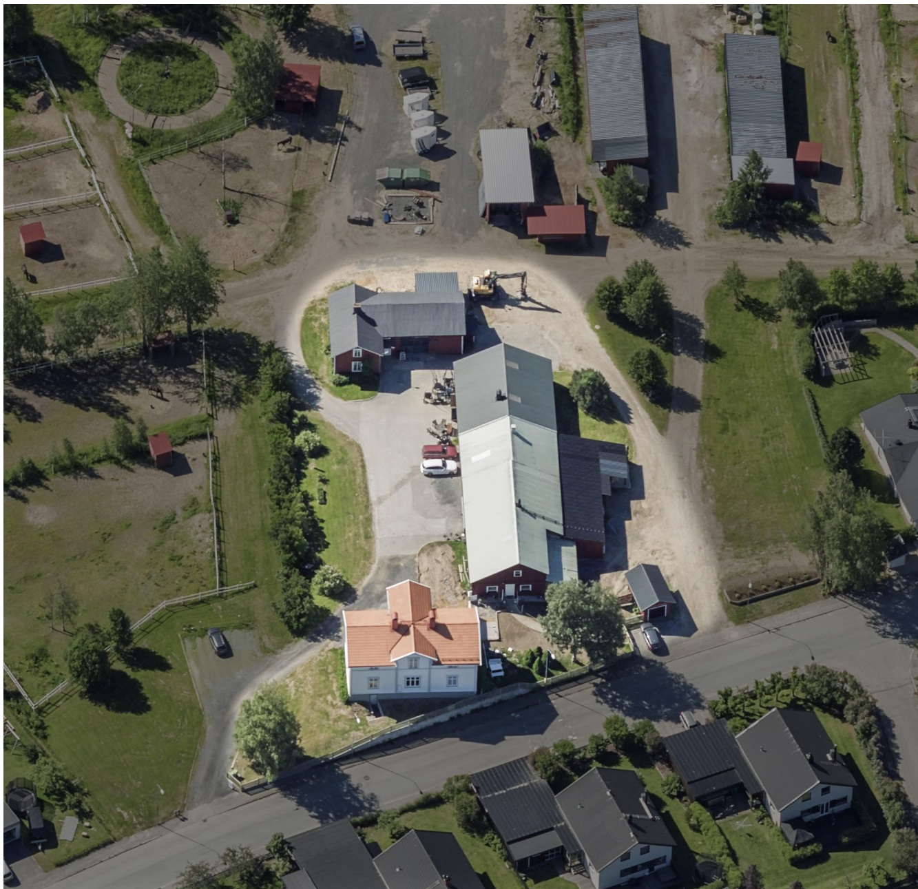
Figur 18. Kulturhistorisk värdefull byggnad samt tillhörande ladugård och uthus inom fastighet Österteg 2:78.
